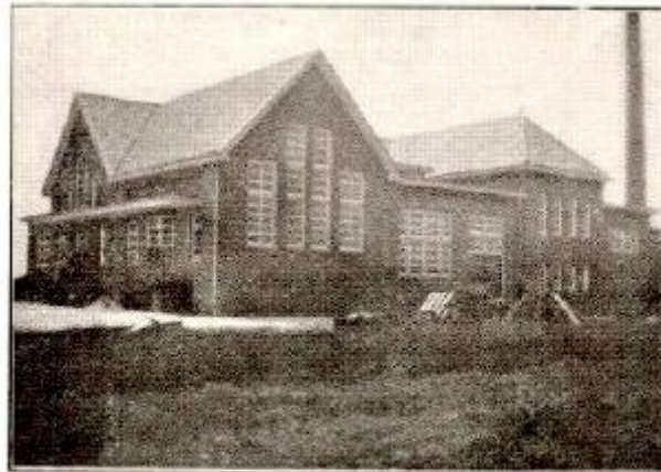
EEN MODERNE STOOMZUIVELFABRIEK: STRAMPROY-TUNGELROY.
