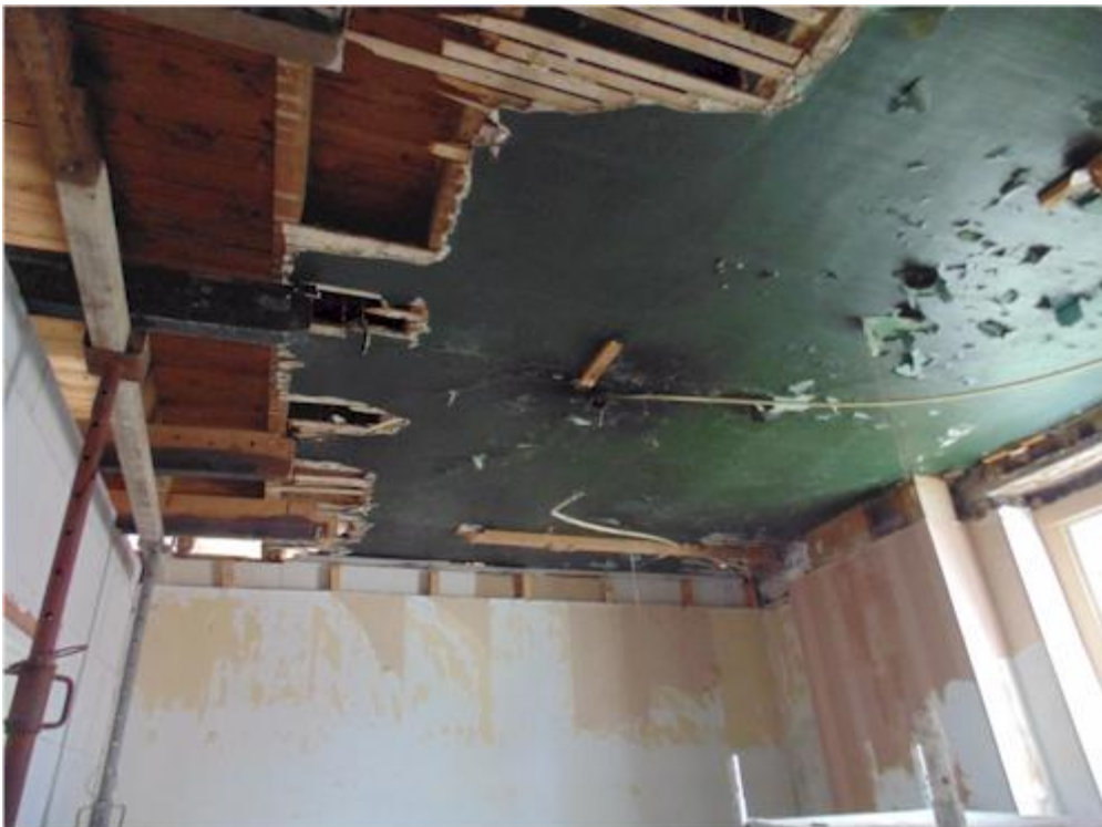
Het plafond van de voormalige woonkamer
