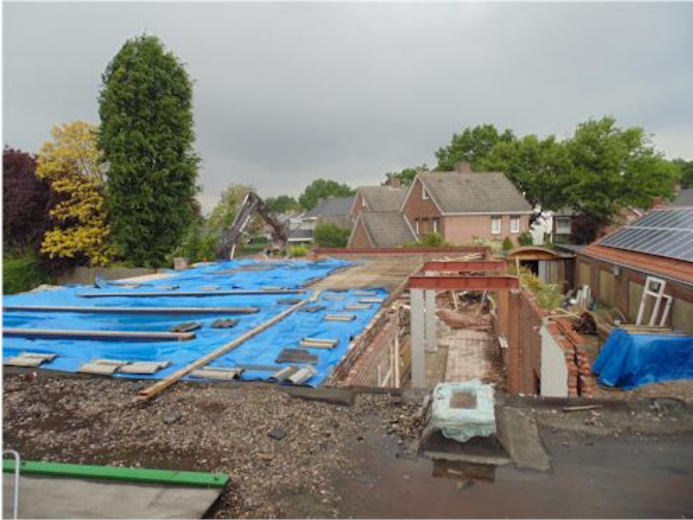
Vanaf het dak van de slaapkamer
