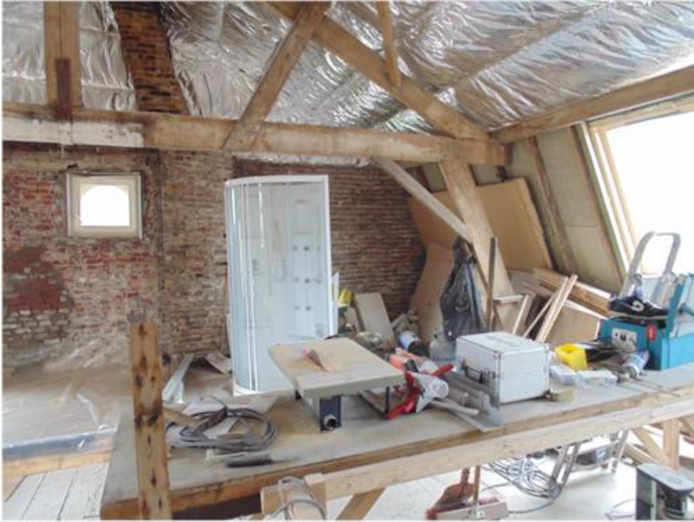
Bovenverdieping. Alle wanden zijn eruit. Momenteel is dit één ruimte
